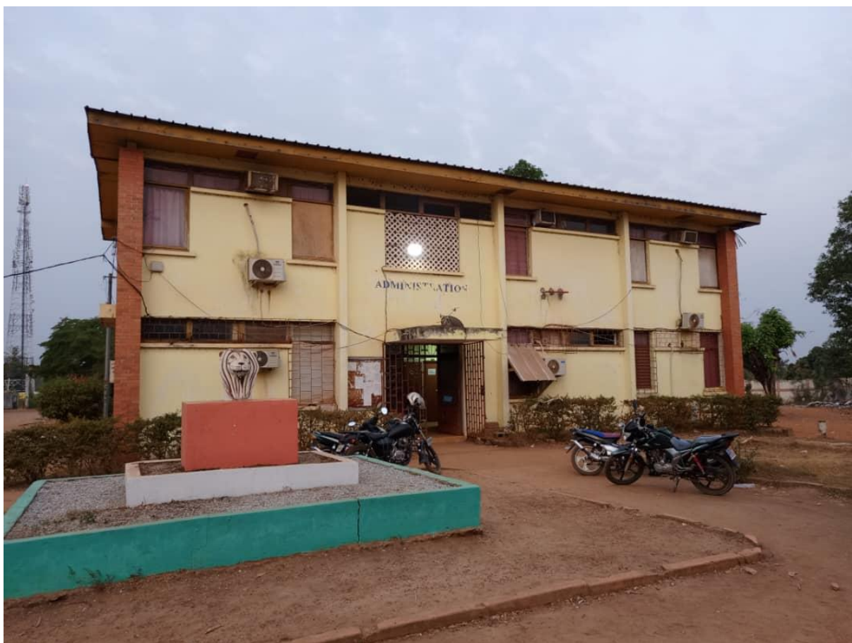
Figure 2 : Administration du Lycée Moderne 1 de Toumodi
