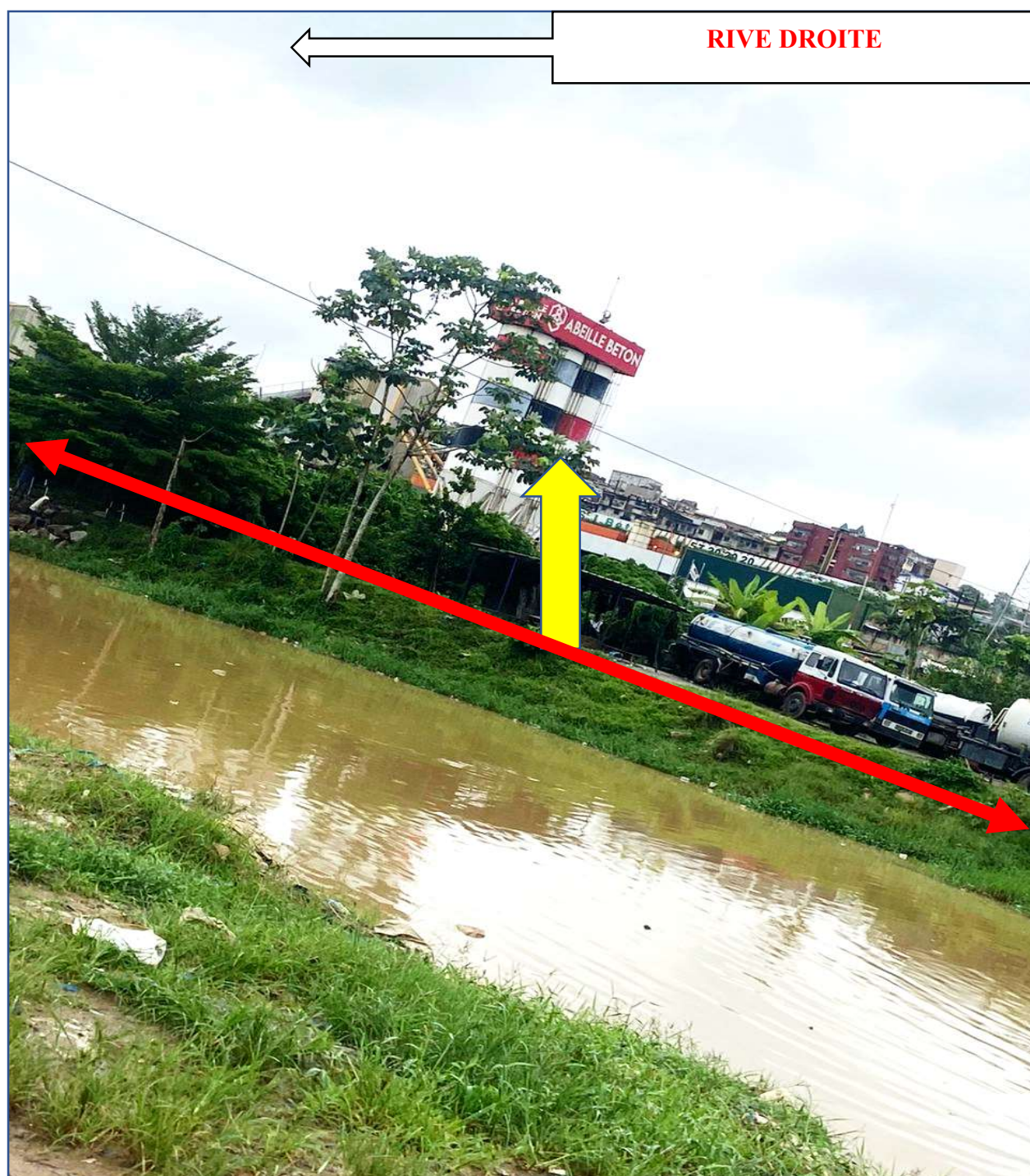
Photo 1 : Vue d'une infrastructure industrielle implantée dans la rive droite de la baie du banco
