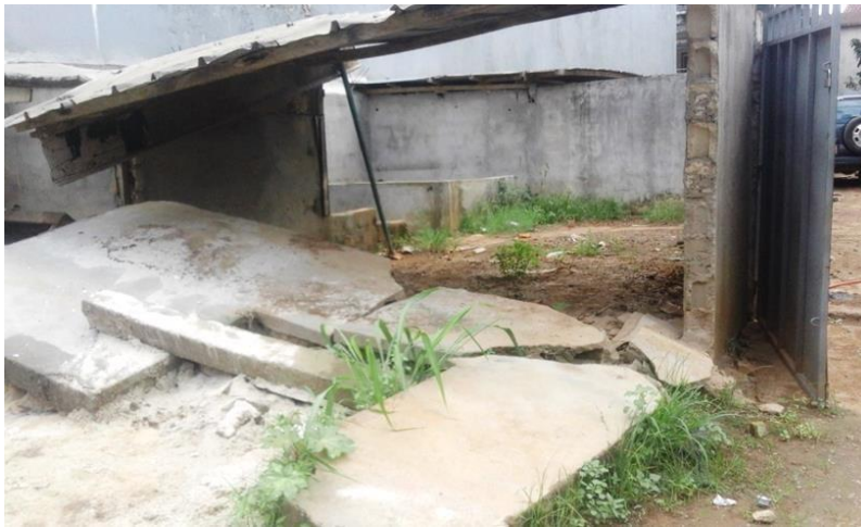
Photo n°2: Mur tombé à la suite des inondations des 18 et 19 Juin 2018 à Palmeraie
